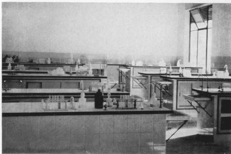
Aula-Laboratorio de Física y Química
